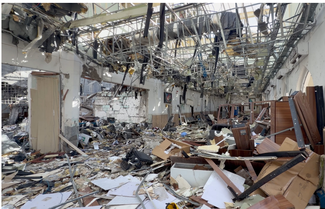
تخریب ساختمان عملیات دریایی و بندری و برج کنترل بندر لنگه بر اثر حمله آمریکایی - صهیونی
