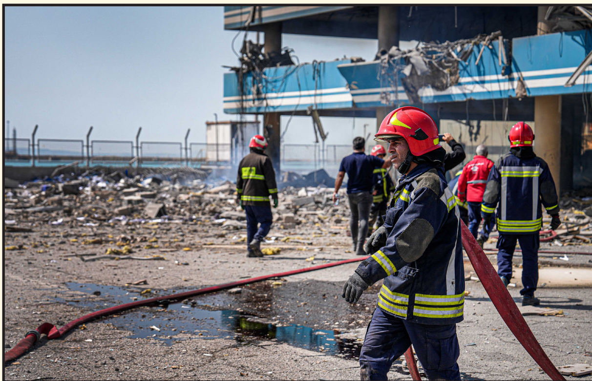
حضور نیروهای آتش‌نشانی بندر شهید رجایی در محل انفجار ساختمان مرجع دریایی
