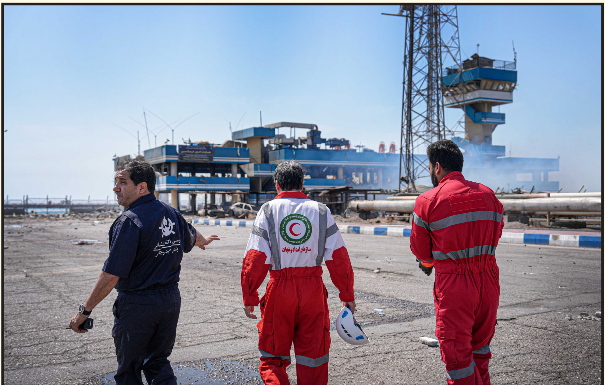
حضور نیروهای هلال احمر در محل انفجار ساختمان مرجع دریایی بندر شهید رجایی
