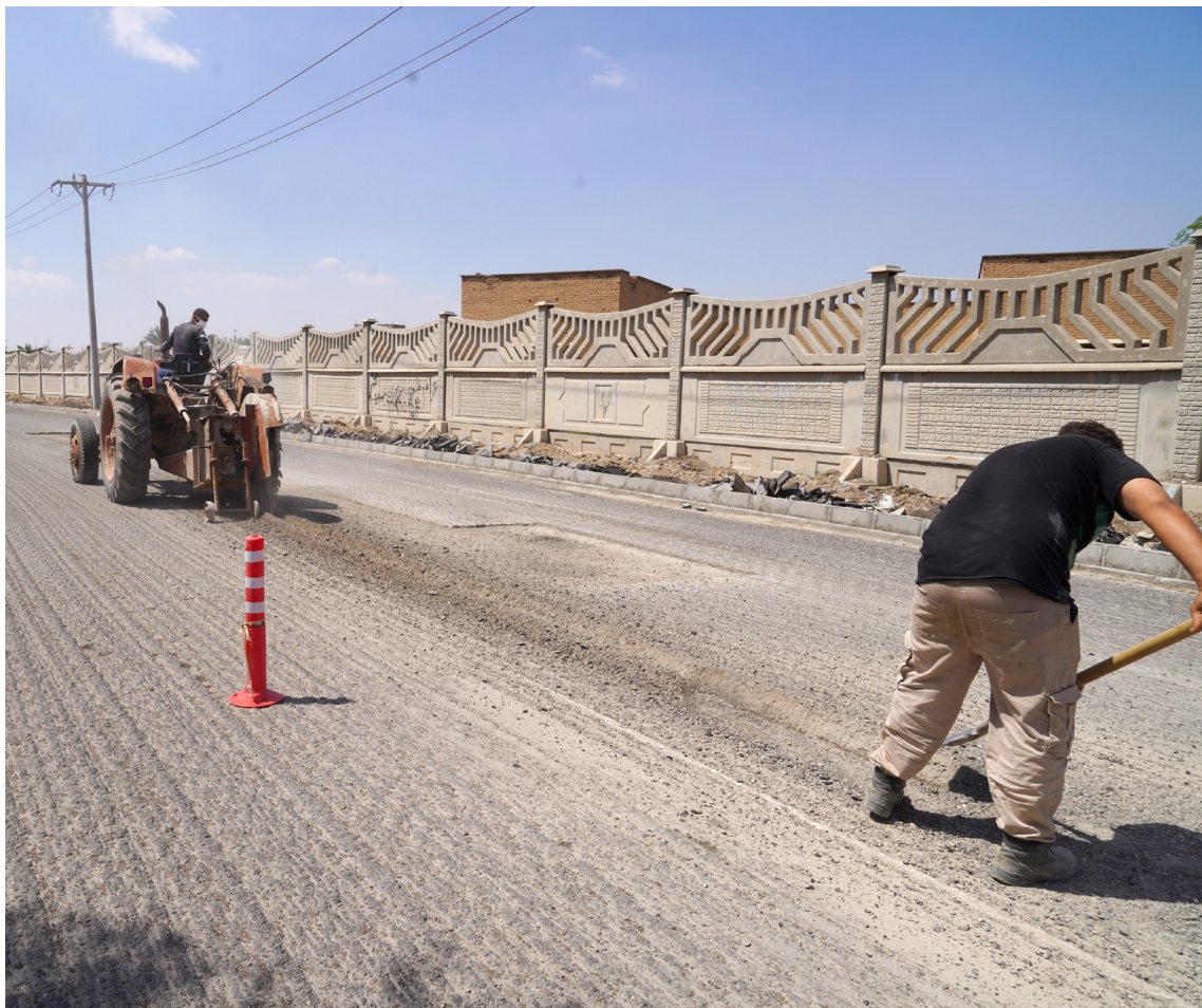
تداوم کسب و کار و انجام عملیات عمرانی در بندر خرمشهر
